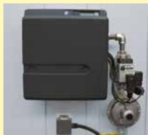
Kompaktbrenner für Standardmodelle bis NB 600
